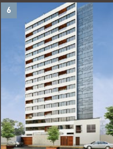
Edificio Neo Tower MAGDALENA
