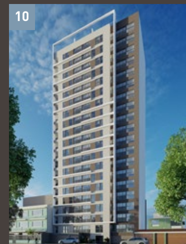
Edificio Dual Tower PUEBLO LIBRE
