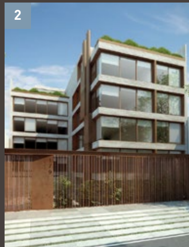
Edificio Romanet 179 SAN ISIDRO
